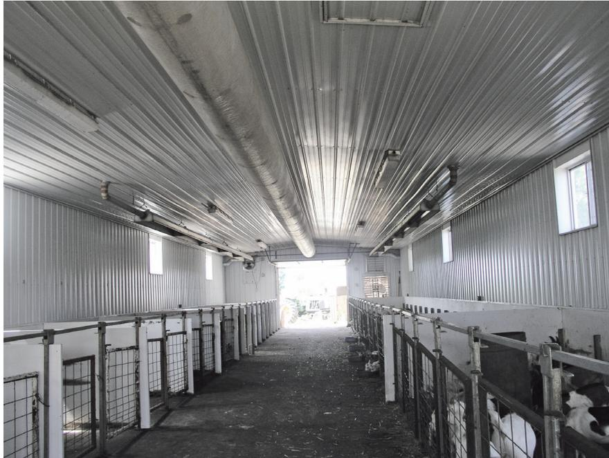
*Sistema de ventilación con tubo de presión positiva.*
